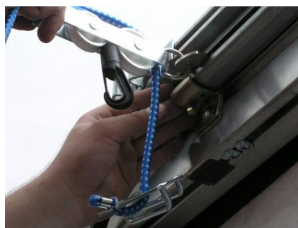
Laufwagen in Profilschiene fügen
