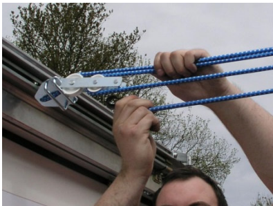
Kunststoffkarabinerhaken der rechten Seite nehmen, zur linken Seite führen und in linke BG Umlenkrolle einhaken
